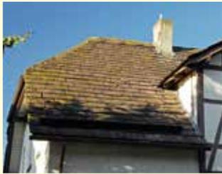
Seit dem Mittelalter wird der **Wesersandstein im Oberweserraum als Baustein geschätzt. Er ist gut zu bearbeiten und witterungsbeständig. Bestimmte Schichten lassen sich gut in zwei bis drei Zentimeter dicke Platten spalten, die sich hervorragend zur Dach-**
